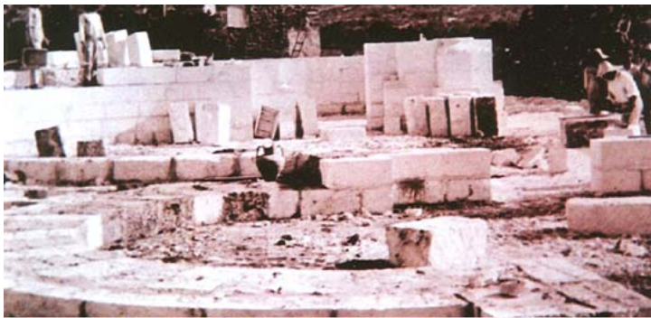
Aquesta és la foto més antiga que tenim de la construcció de la nostra església de Son Carrió. Seria per a mitjan juny de 1899
